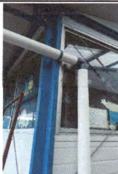
Foto 3: Falta de canales y bajadas de agua
