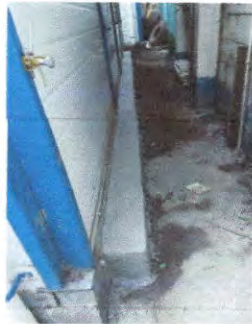
Foto 9: Colocación de block para cerrar costado de aulas.
