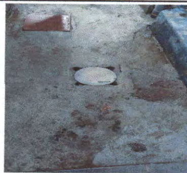
Foto 12: instalacion de reposaderas
