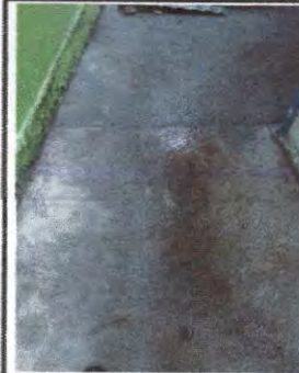
Foto 8: Levantado de pared y fundición de concreto
