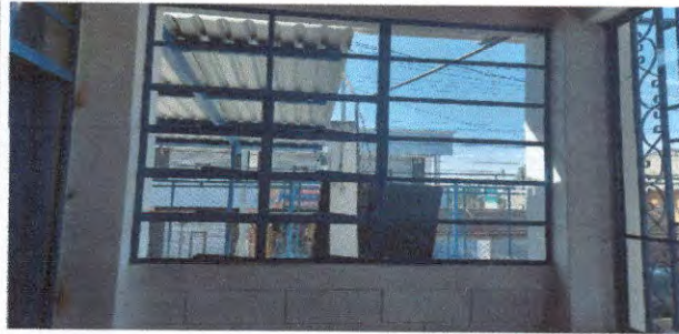
Foto 8: sustitucion de ventana
