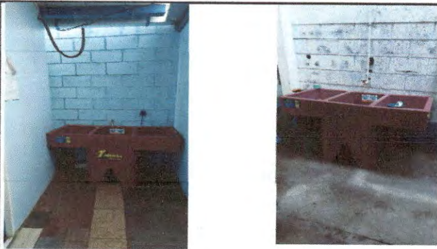
Foto 9: Instalacion de pilas 2
