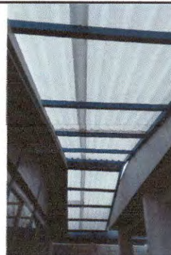
Foto 4: Cierre de superficie abierta de módulos
