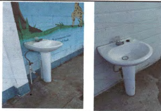
Foto 10: Instalacion de lavamanos
