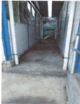
Foto 7: Fundición de concreto
