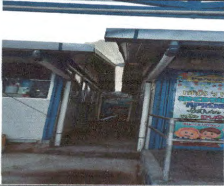
Foto 7: Instalacion de techo para union de aulas.
